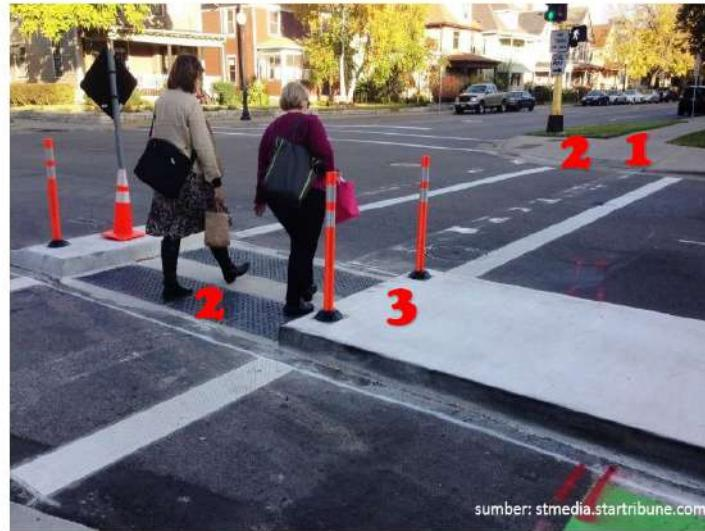
Rajah 4.13: Contoh median yang dilengkapi dengan *warning block* di lintasan pejalan kaki.
