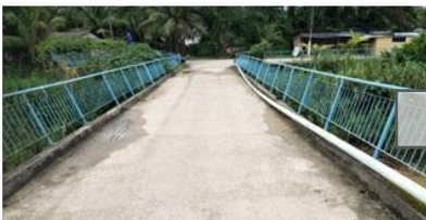
Keadaan semasa Jambatan Semasa Jalan Sungai Tiram Off
