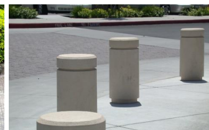
Perletakan bollard bagi menghalang kenderaan bermotor
