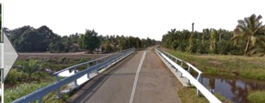
Keadaan selepas menaiktaraf jambatan dan ilustrasi bagi jambatan baru
