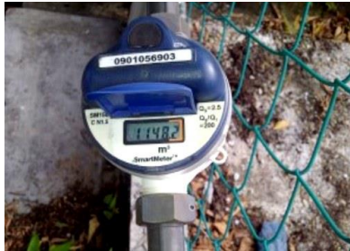
Smart Meter Digital yang membolehkan pembacaan meter air yang lebih tepat
