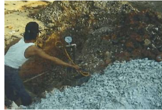
Kerja-kerja penggantian paip usang yang sedang dilakukan
