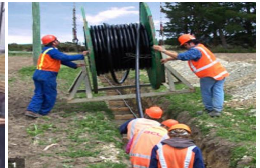
Penyelenggaraan Paip Utiliti
